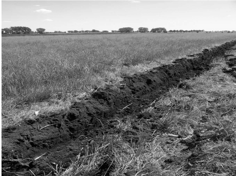
Fot. 1. Świeżo wykopany rów melioracyjny odwadniająco badany teren Photo 1. Recently dug drainage ditch dehydrating investigated area
