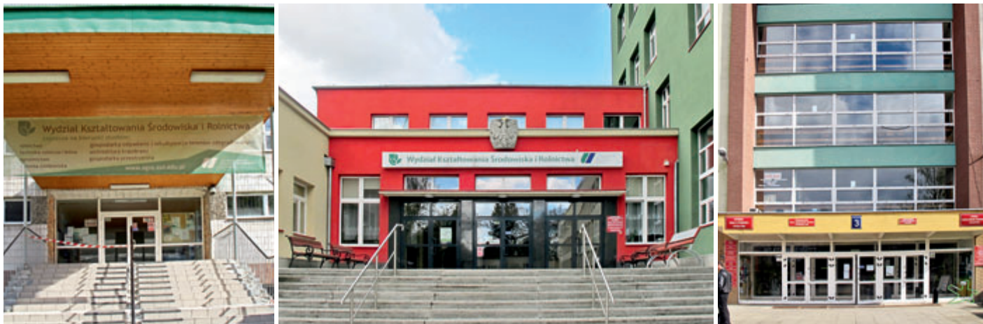
Budynki Wydziału przy ul. Juliusza Słowackiego i Papieża Pawła VI
