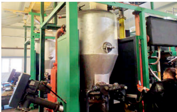
Widok gazogeneratora z systemem transportu zrębków oraz popiołu
