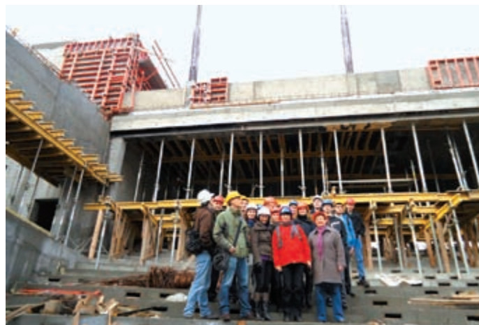
W tle audytorium w trakcie realizacji
