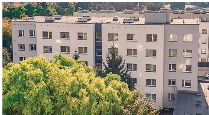
Widok na Hotel Asystencki przy ul. Chopina 51 po remoncie elewacji
