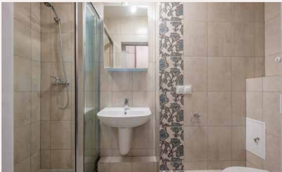
Nowa łazienka z toaletą i prysznicem
