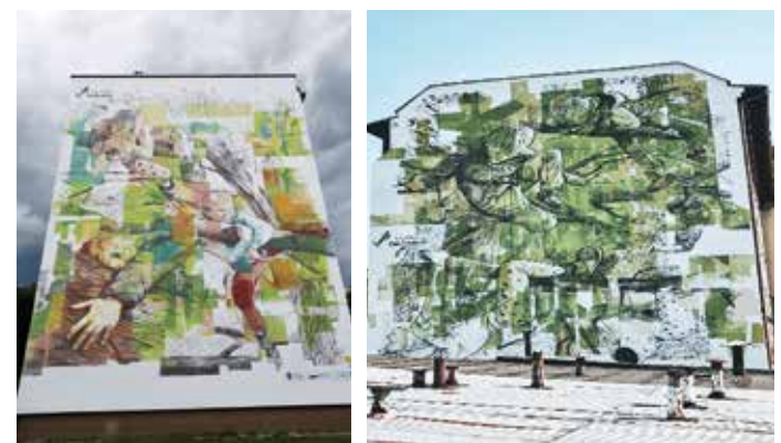
Ryc. 12. Przykładowe aplikacje farb fotoaktywnych firmy Pigment ze Szczecina: (a) Gdański Part Naukowo-Technologiczny; (b) budynek Centrum Badawczo-Dydaktycznego Nanotechnologii ZUT w Szczecinie (rok wykonania 2021); (c) mural w Szczecinie (rok wykonania 2021); (d) mural w Szczecinku (rok wykonania 2021) Źródło: Archiwum firmy Pigment.
