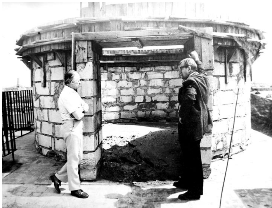
Obserwatorium Astronomiczne w budowie
